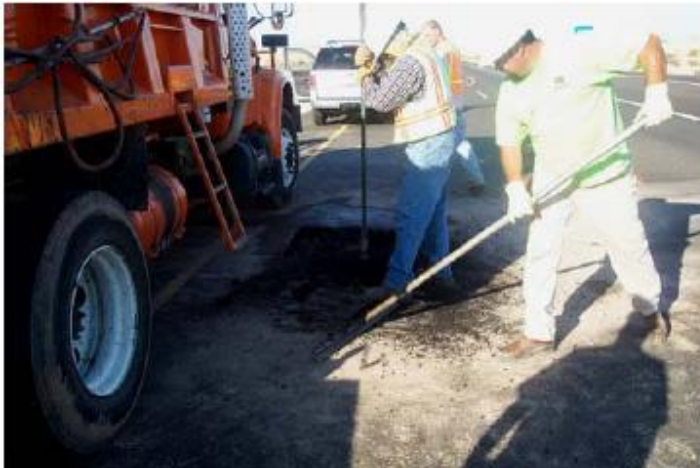
شکل ۳-۱- روش ریختن و غلتک زدن
