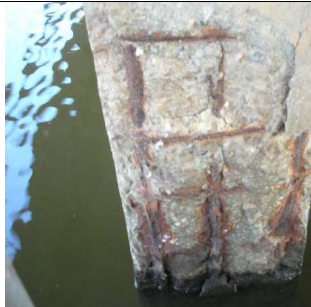
در بتن پوسته‌شدگی و تورق وسیع وجود دارد.
