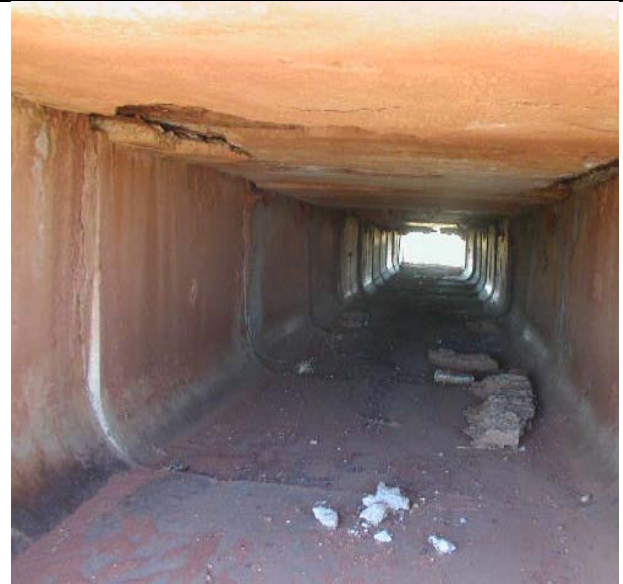
در بتن پوسته‌شدگی و تورق وسیع وجود دارد.
