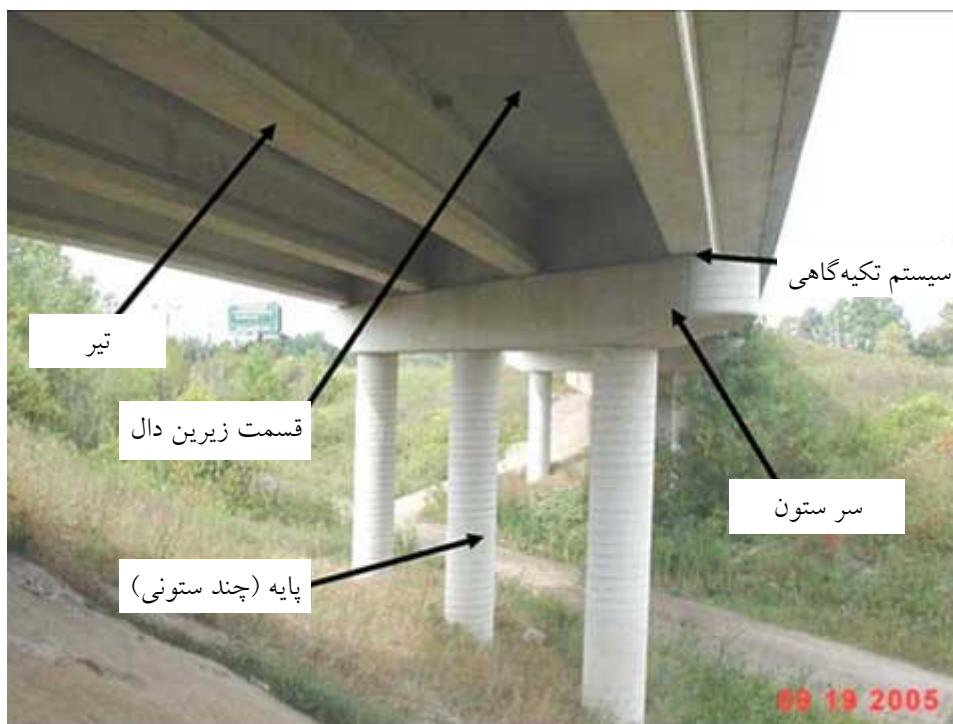
شکل شماره ۳: نمایش اعضای متداول پل از زیر عرشه
