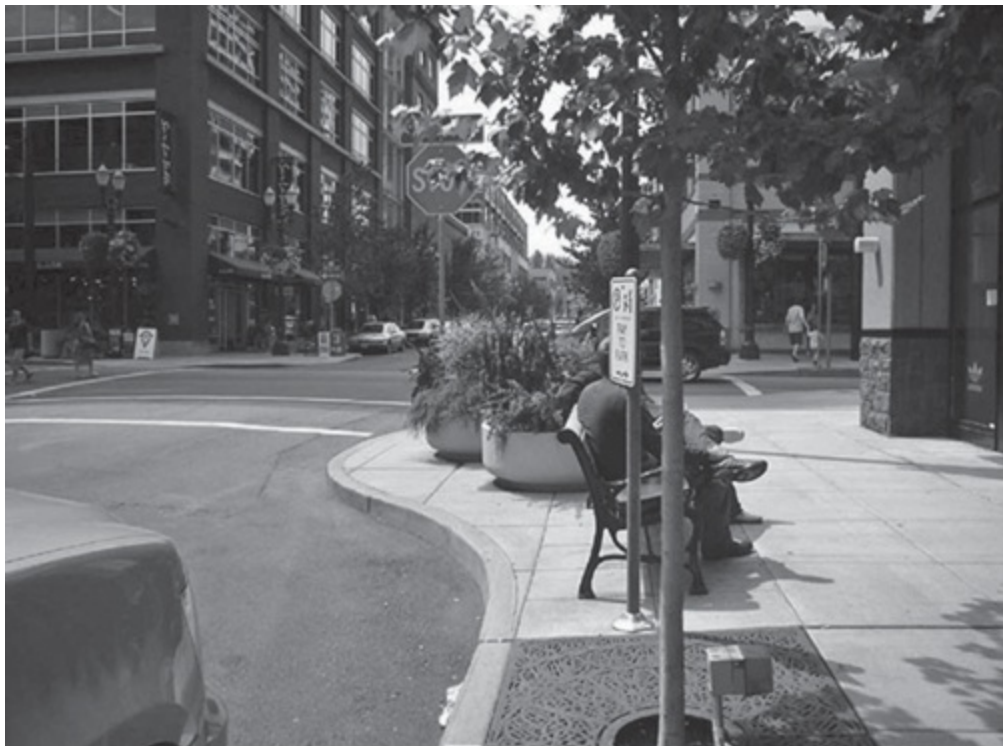
(d) Curb Extension Reduces Crossing Distance
